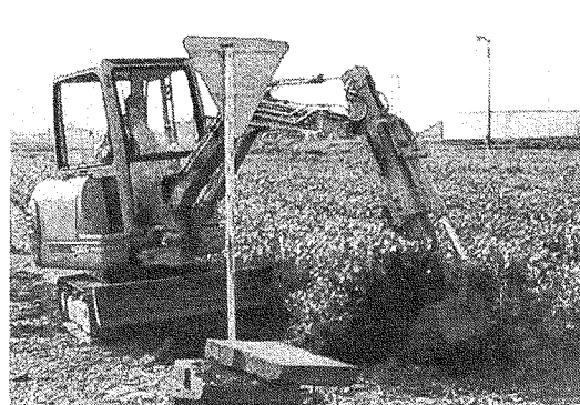
写真2 バックホーによる抜根
